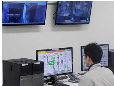
制御室 試験作業状況
