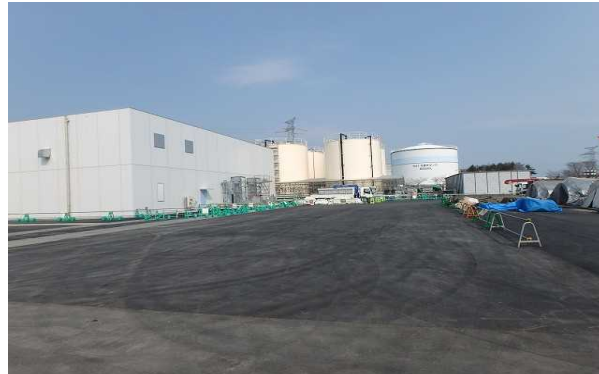
【写真④(35m盤)】山側法面エリア:大熊通り法肩部モルタル施工後
