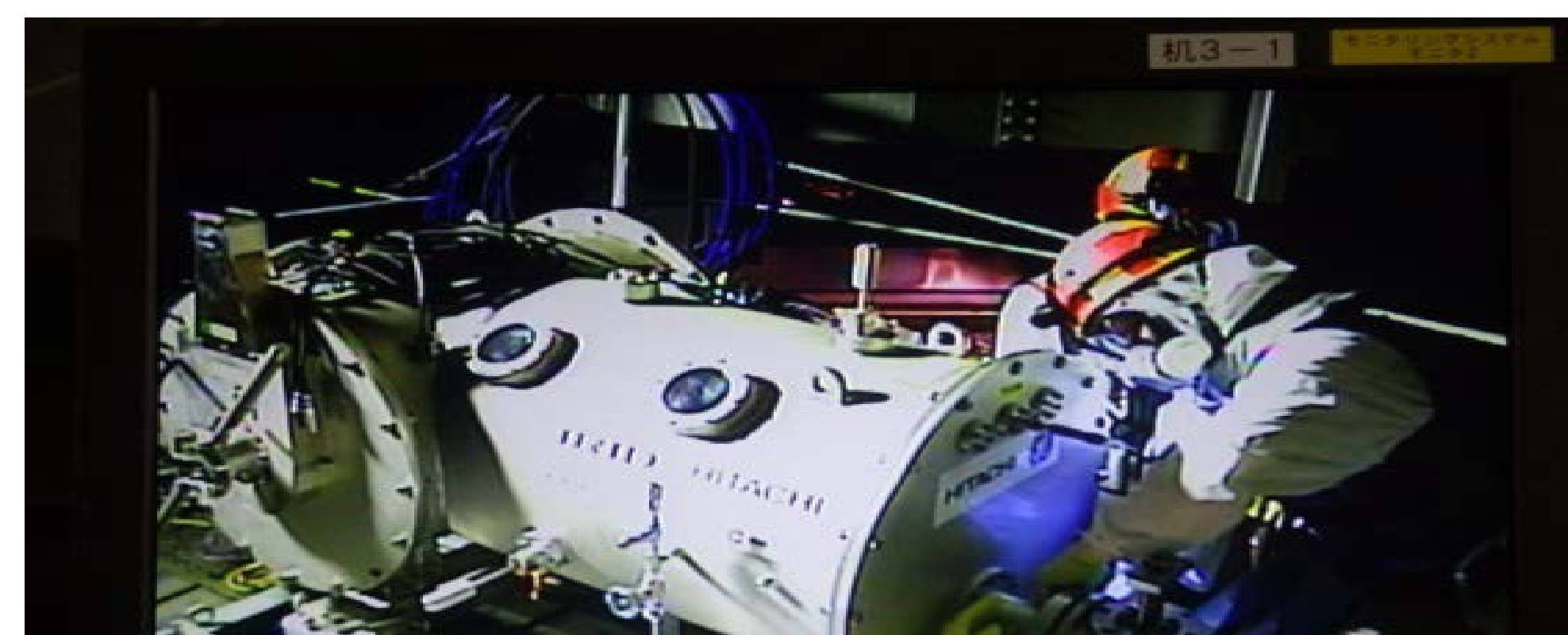
X-100Bペネ近傍でのPCV内への投入作業
