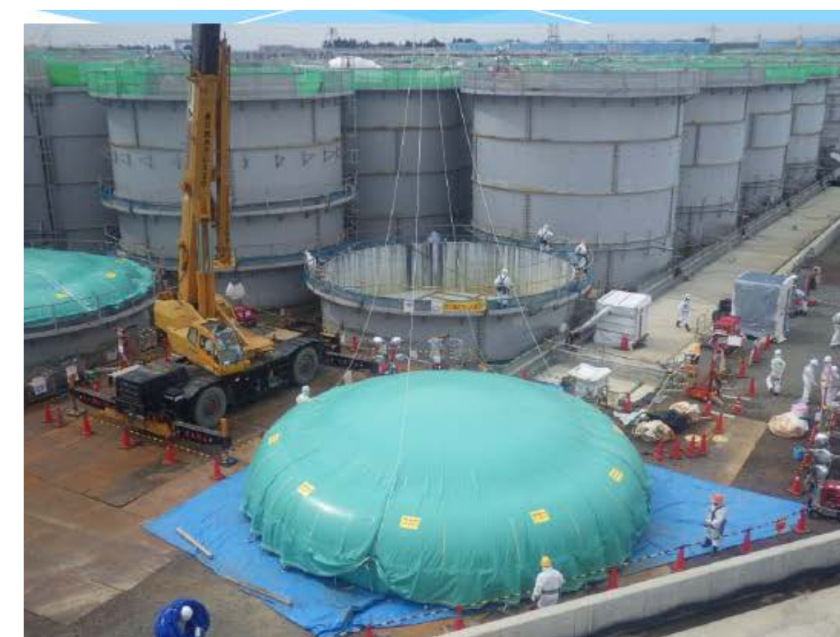
飛散抑制のための屋根を設置 (屋根重量=300kg/基)
