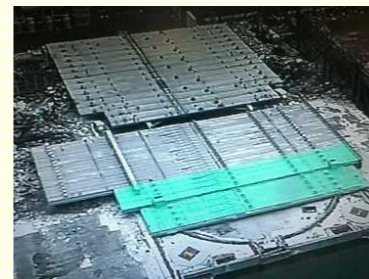
<遮へい体の設置状況>
