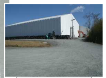
瓦礫保管テント
