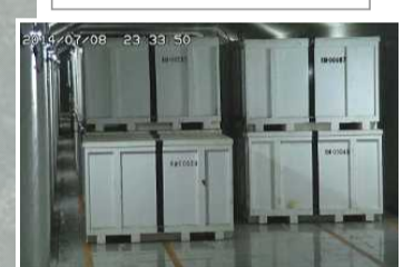
固体廃棄物貯蔵庫
