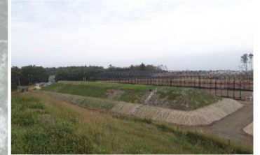
覆土式一時保管施設
