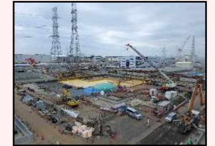
H1東エリア解体後の様子
