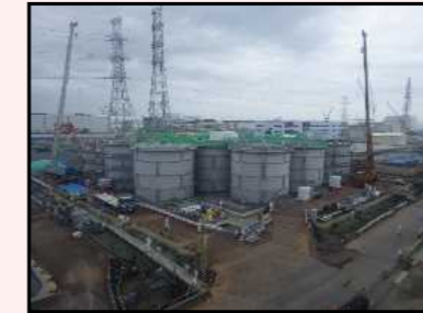
H1東エリア解体開始時の様子
