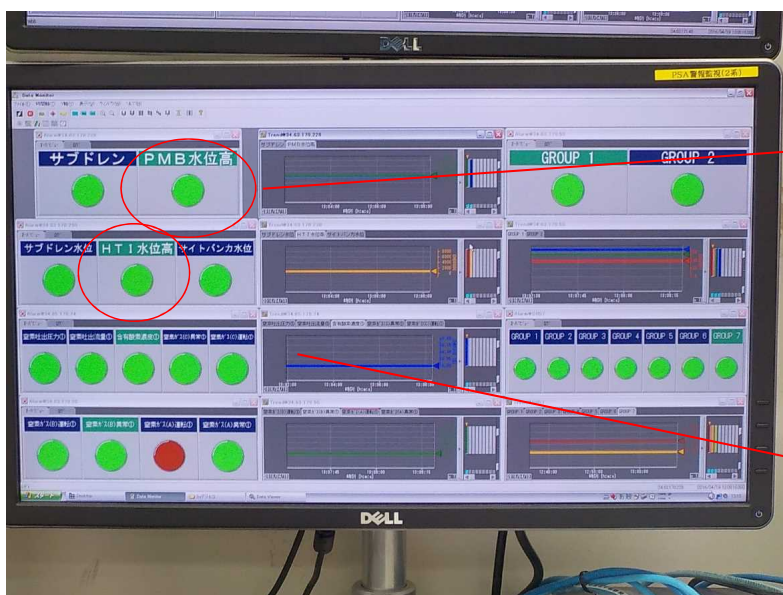
監視画面全景
