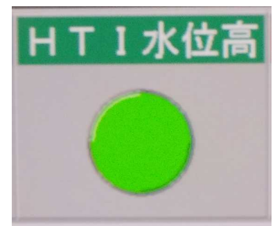
高温焼却炉建屋 (HTI) 水位高警報窓
