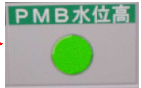
プロセス主建屋 (PMB) 水位高警報窓
