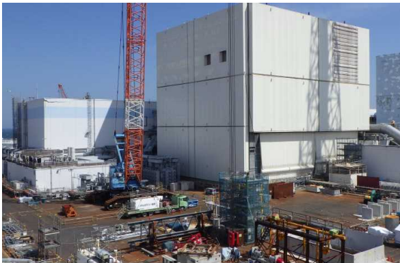
撮影：H28.4.23 全景(北西面)
