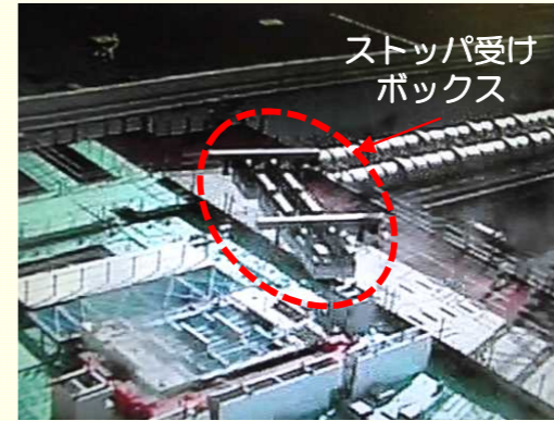
＜ストッパ設置作業の状況＞
