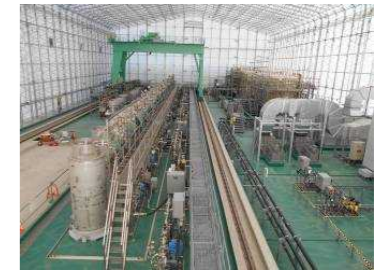
(高性能多核種除去設備)
