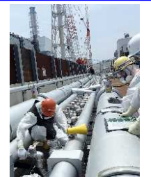
(凍結管バルブ開閉操作の様子)
