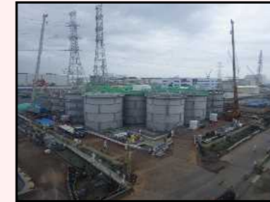
H1東エリア解体開始時の様子
