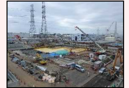
H1東エリア解体後の様子
