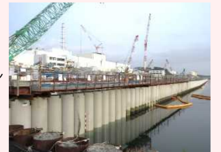
海側遮水壁 鋼管矢板打設完了状況
