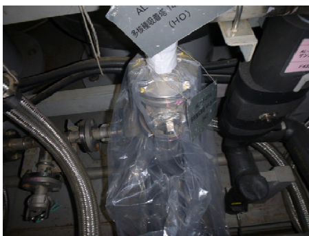
滴下発生箇所（袋養生実施後）
