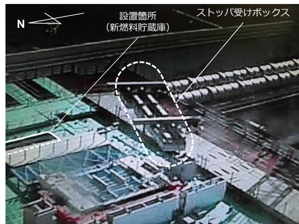
ストッパ受けボックス設置状況（撮影日2017年1月17日）
