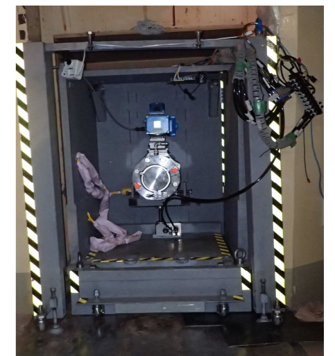
2号機X-6穴あけ完了後の現場状況
