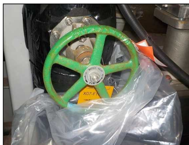
ろ過処理水受タンクA入口弁 (当該弁のグランド部より漏えい)
