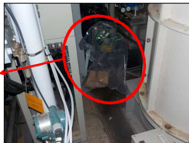
ろ過処理水受タンクA入口弁 (当該弁のグランド部より漏えい)
