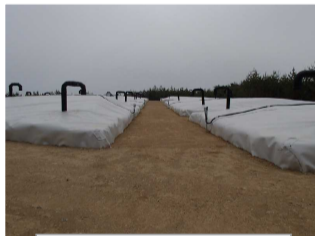
伐採木一時保管槽
