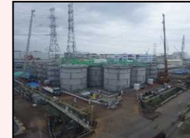
H1東エリア解体開始時の様子
