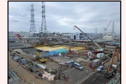
H1東エリア解体後の様子
