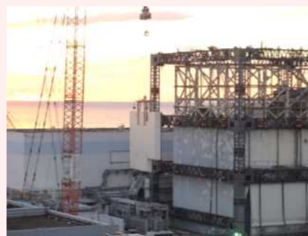
<壁パネル取り外し状況>
