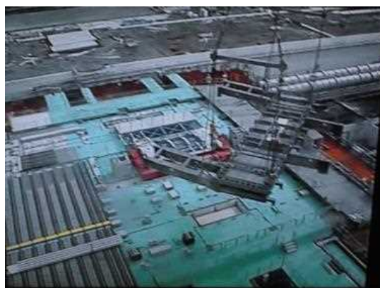
西側ストッパ設置状況（撮影日2017年2月7日）
