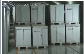
固体廃棄物貯蔵庫
