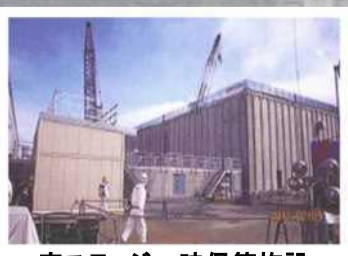
廃スラッジ一時保管施設
