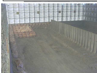
瓦礫保管テント内
