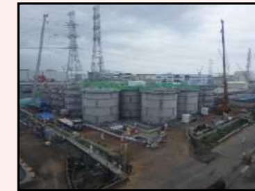
H1東エリア解体開始時の様子
