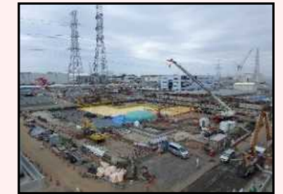
H1東エリア解体後の様子
