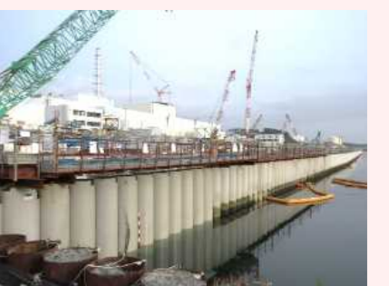
海側遮水壁 鋼管矢板打設完了状況
