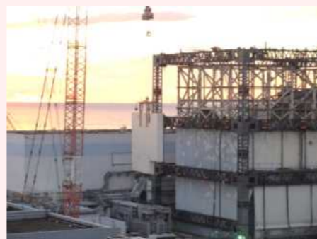
<壁パネル取り外し状況>
