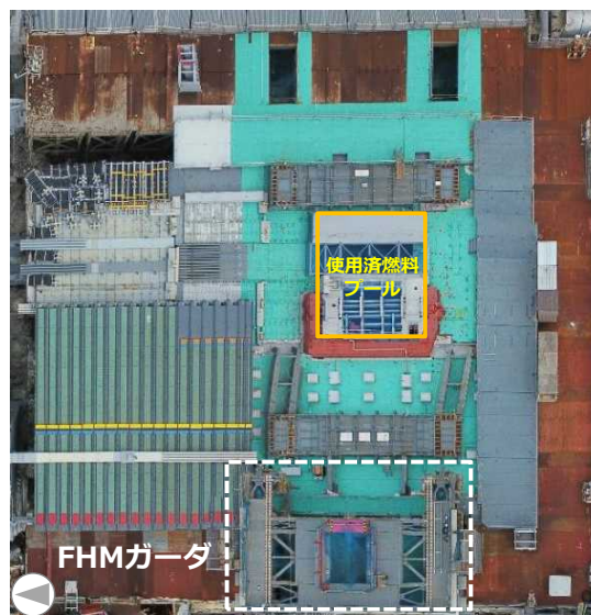
FHMガード設置作業中（撮影日2017年3月13日）
