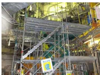
X100Bペネ下 (作業架台：高さ約4m)
