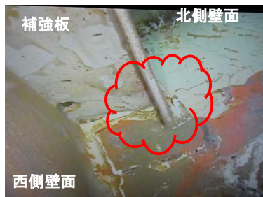
【Ⅱ部】（矢視A）約4cmの割れ
