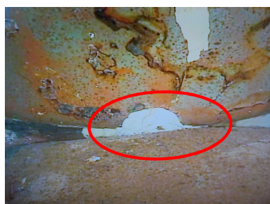
【Ⅲ部】突起物切断、内面肉盛り溶接、 外部あて板溶接＋パテ補修
