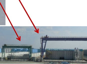
使用済吸着塔一時保管施設
