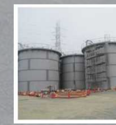
地下水バイパス一時貯留タンク
