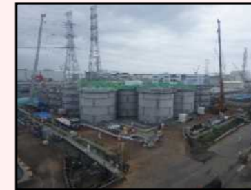
H1東エリア解体開始時の様子
