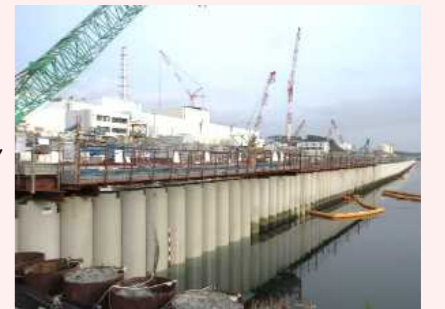
海側遮水壁 鋼管矢板打設完了状況
