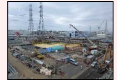
H1東エリア解体後の様子
