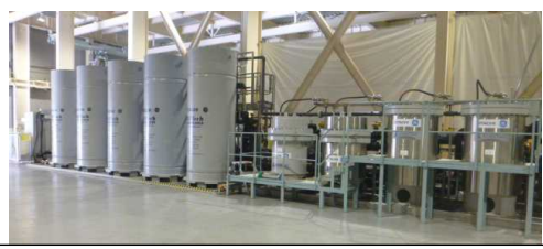
サブドレン他浄化設備 (B系)
