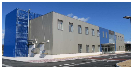
国際共同研究棟の外観
