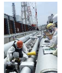
(凍結管バルブ開閉操作の様子)
