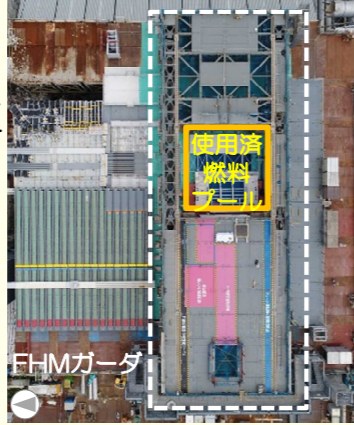
＜FHMガーダ設置の進捗状況＞
