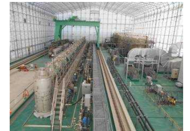
(高性能多核種除去設備)
