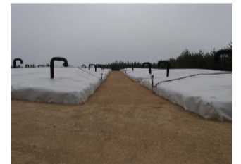
伐採木一時保管槽
