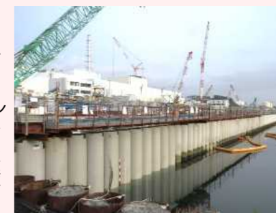
海側遮水壁 鋼管矢板打設完了状況
