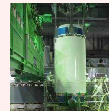
燃料取り出し状況
