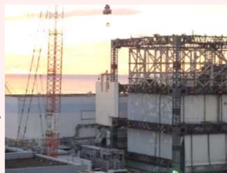
<壁パネル取り外し状況>
