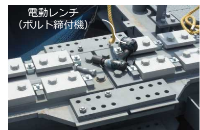
FHMガーダブロックのボルト接合箇所例
