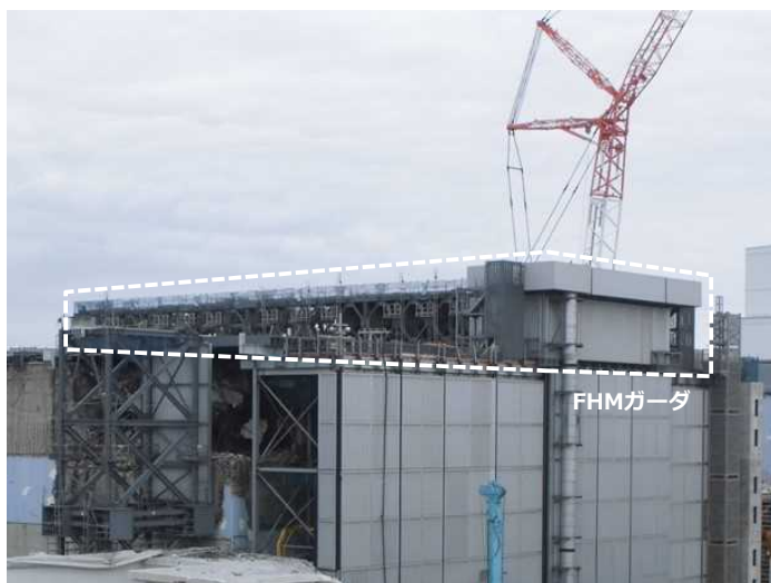
FHMガーダ建方状況（撮影日2017年5月10日）
