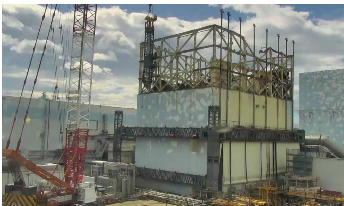
北西柱取り外し (5/11)
