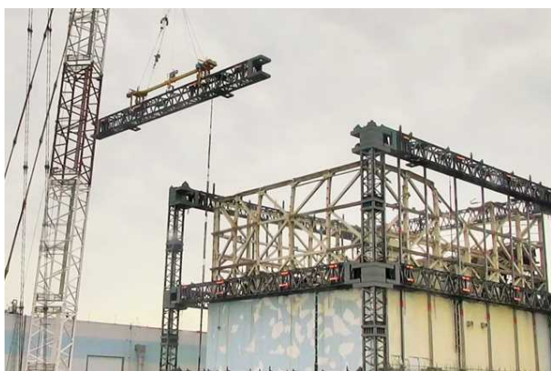
上段北梁取り外し (3/31)
