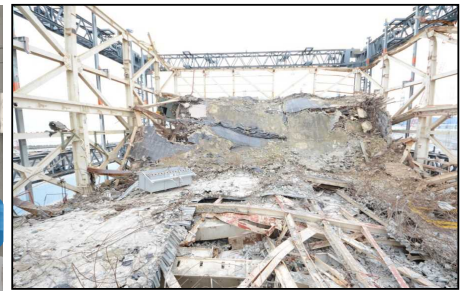
崩落屋根状況
