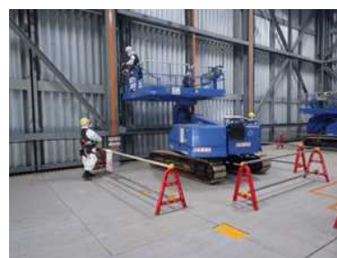
写真② 前室壁隙間塞ぎ作業状況
