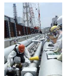
(凍結管バルブ開閉操作の様子)
