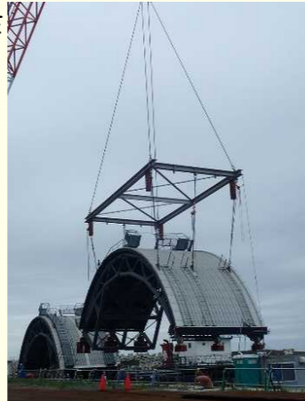
<ドーム屋根構内搬入>
