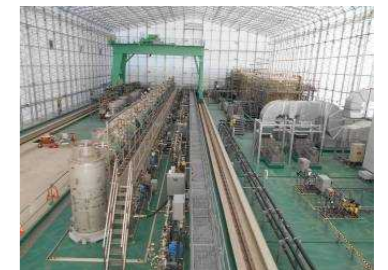
(高性能多核種除去設備)
