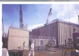
廃スラッジ一時保管施設
