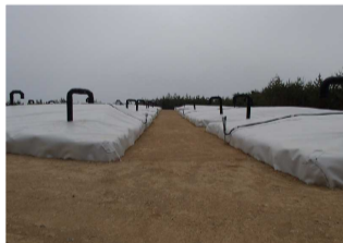
伐採木一時保管槽
