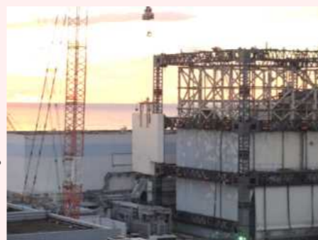
<壁パネル取り外し状況>
