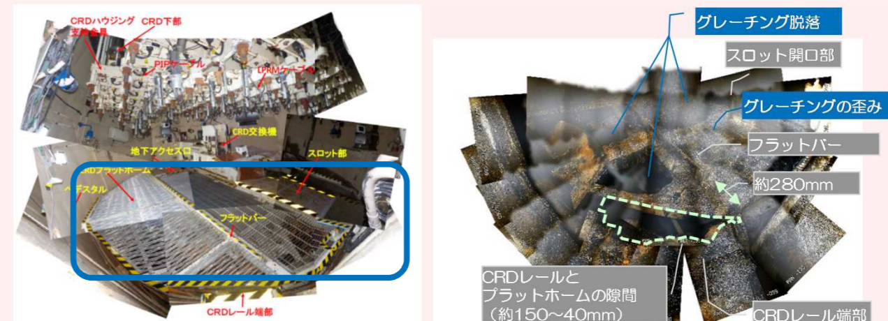
(参考) 5号機のペDESTAL内、ペDESTAL内部の状況
