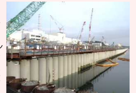
海側遮水壁 鋼管矢板打設完了状況
