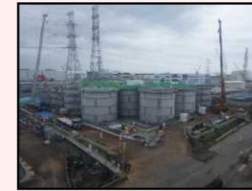
H1東エリア解体開始時の様子
