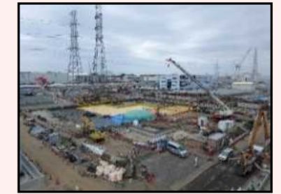
H1東エリア解体後の様子
