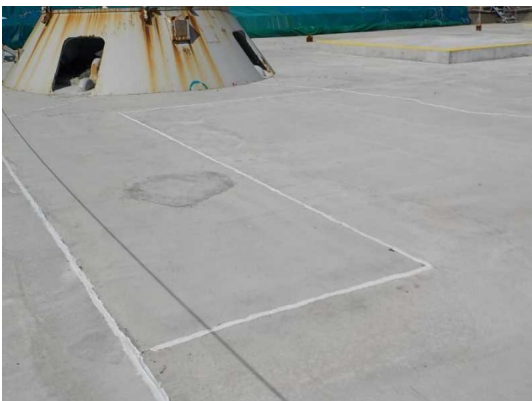
4m盤フェーシング継手止水
