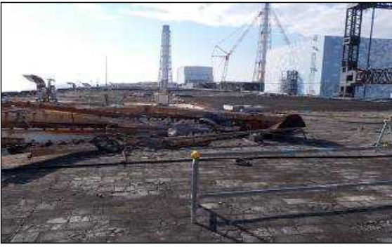
【施工前】1号機T/B屋上
