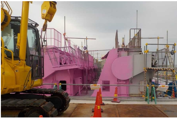
集水タンク増設（2号機除塵機撤去前）
