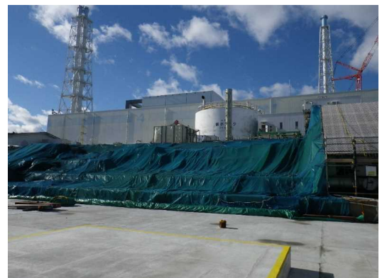
7.5m盤法面シート架け
