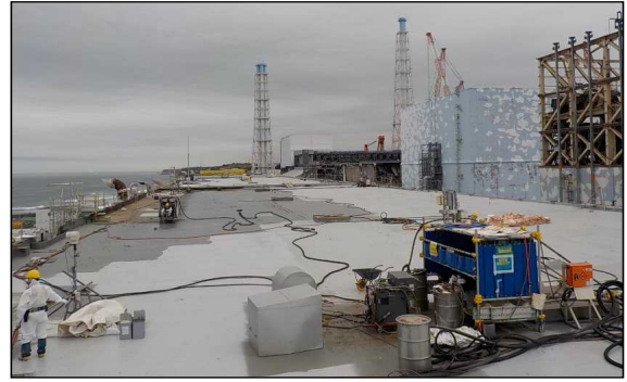
【現況】1号機T/B屋上
