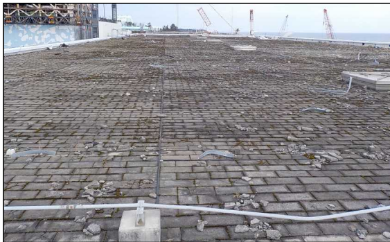
【施工前】2号機T/B屋上
