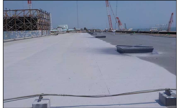
【現況】2号機T/B屋上
