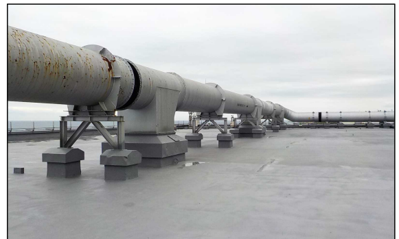
【現況】4号機T/B屋上
