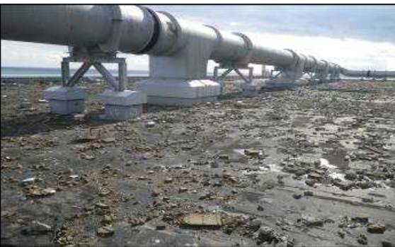
【施工前】4号機T/B屋上
