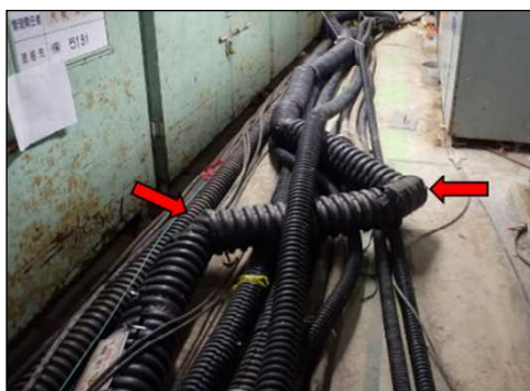
現状のSUSフレキシブルチューブの曲がりの状態
