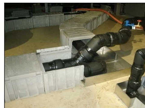
PE管施工イメージ
