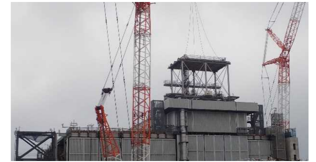
3号機燃料取り出し用カバー設置状況 (2017/7/26)
