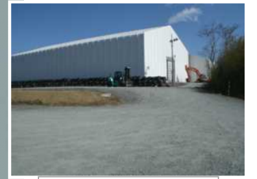
瓦礫保管テント
