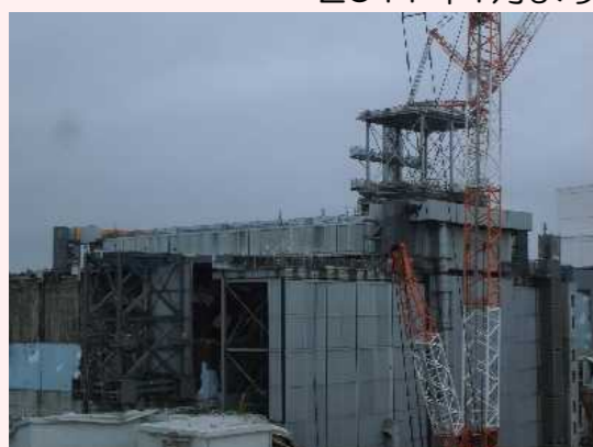
燃料取り出し用カバー設置状況(2017/7/26撮影)
