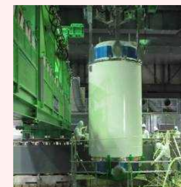
燃料取り出し状況
