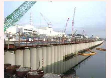
海側遮水壁 鋼管矢板打設完了状況
