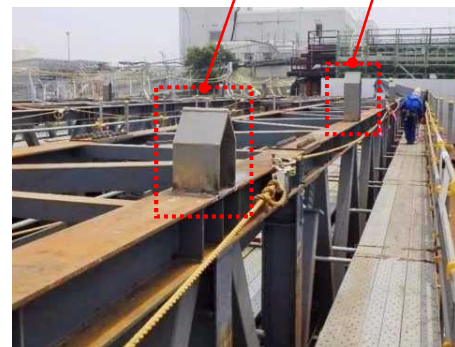
カバー梁改造 撮影：H29.7.10
