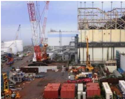
工事エリア全景 撮影：H29.7.24
