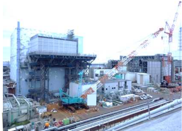
2号機原子炉建屋 全景（2017.6.27撮影）
