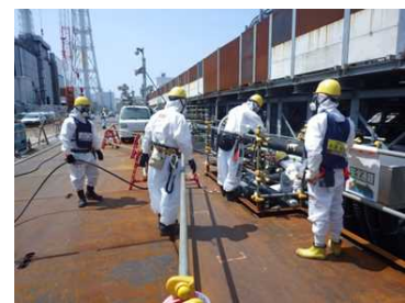
写真③ ケーブル敷設作業状況
