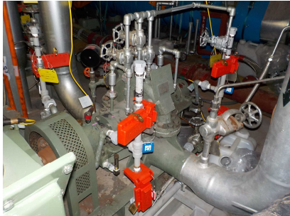
①閉止栓の取付
