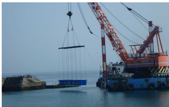
設置状況（作業全景）
