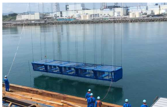
設置状況（作業近景）
