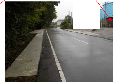
道路の西側路肩部分
