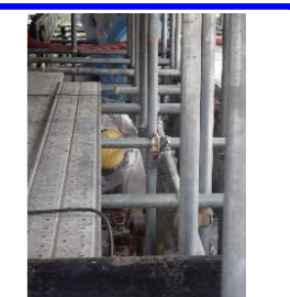
(凍結管バルブ 開閉操作の様子)
