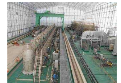
(高性能多核種除去設備)
