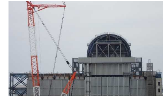
3号機燃料取り出し用カバー設置状況 (2017/8/28)
