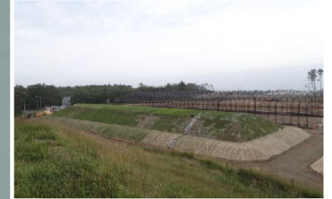
覆土式一時保管施設
