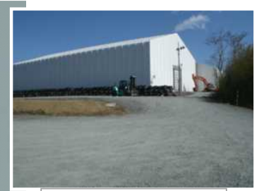
瓦礫保管テント
