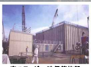
廃スラッジ一時保管施設
