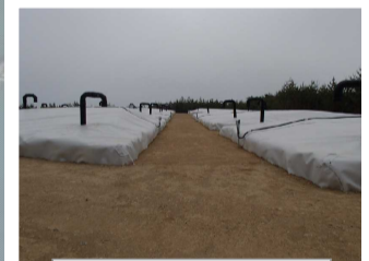
伐採木一時保管槽
