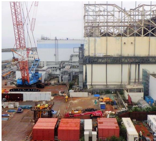
工事エリア全景 撮影：H29.8.28
