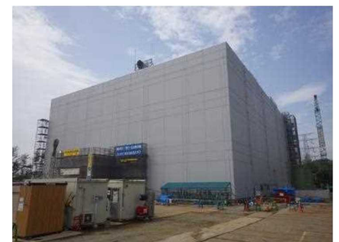
雑固体廃棄物焼却設備（建屋全景）
