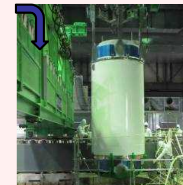
燃料取り出し状況
