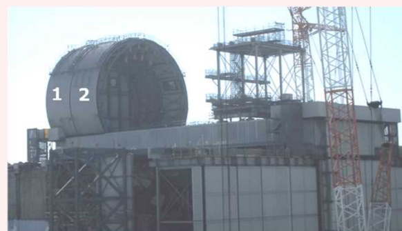
ドーム屋根設置状況(9/26撮影)
